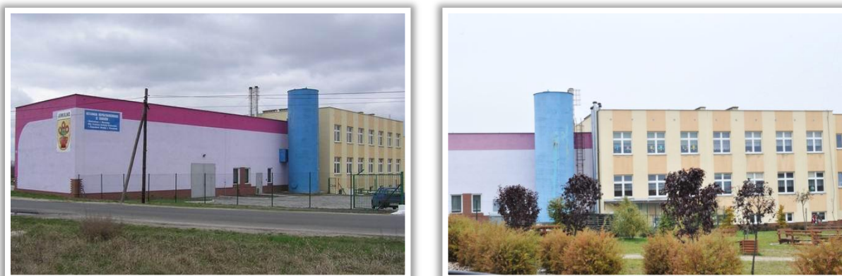
Ryc. 20. Kotłownia opalana słomą przy Zespole Szkół w Jemielnie
